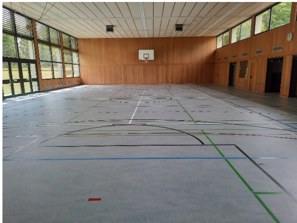
Foto: Sanierter Boden in der Mehrzweckhalle
